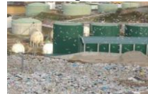
Scandale à l'usine de La Corogne en Espagne
