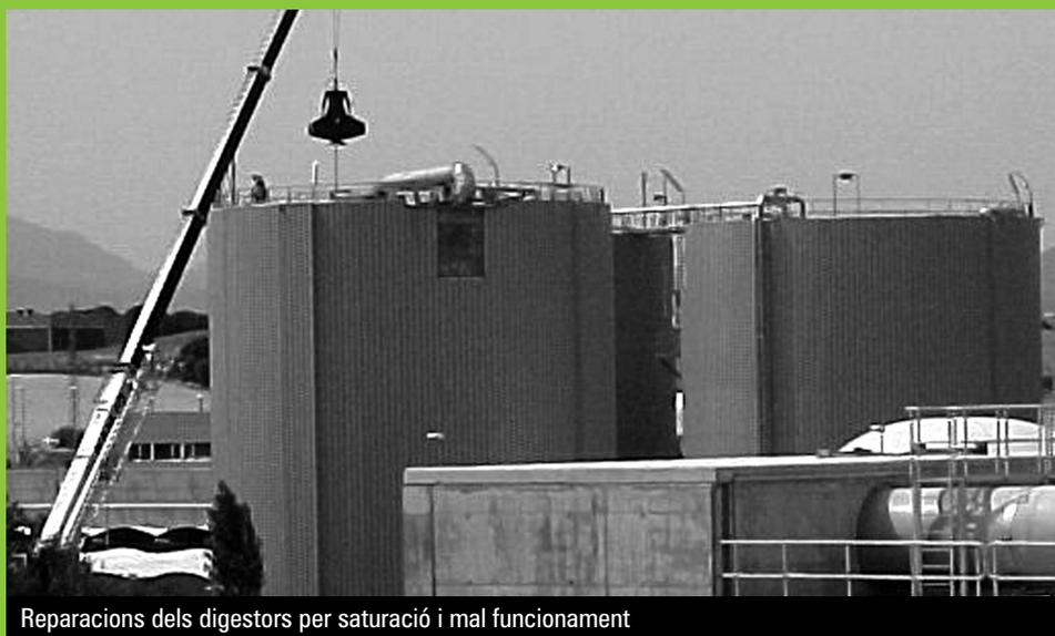
Reparacions dels digestors per saturació i mal funcionament
